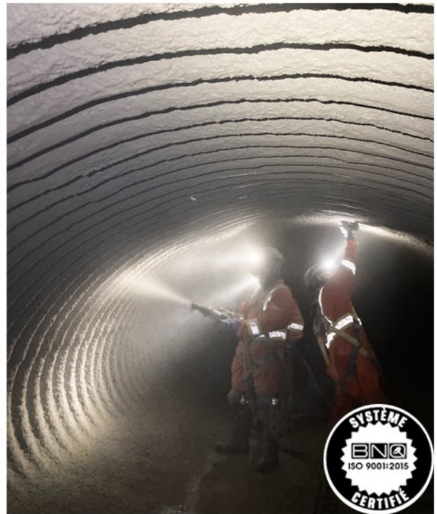
Projection automatisée et manuelle du géopolymère
