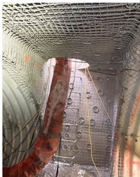
Réhabilitation de la chambre d'accès
