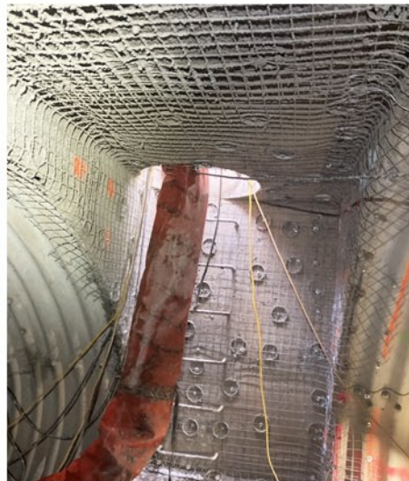
Pose d'un treillis sur les parois de la chambre
